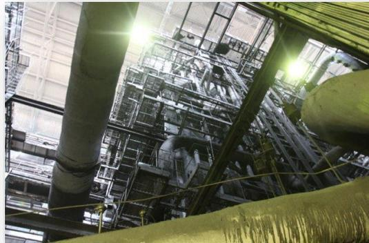
diseñados específicamente para soplar y limpiar la cámara de combustión, lo que asegura que las superficies internas de la caldera se mantengan libres de acumulaciones de ceniza y otros residuos. Este sistema de limpieza es vital para prevenir la reducción del intercambio térmico, mejorar la eficiencia del quemado y reducir la frecuencia de mantenimientos correctivos que podrían detener la operación de la planta.
